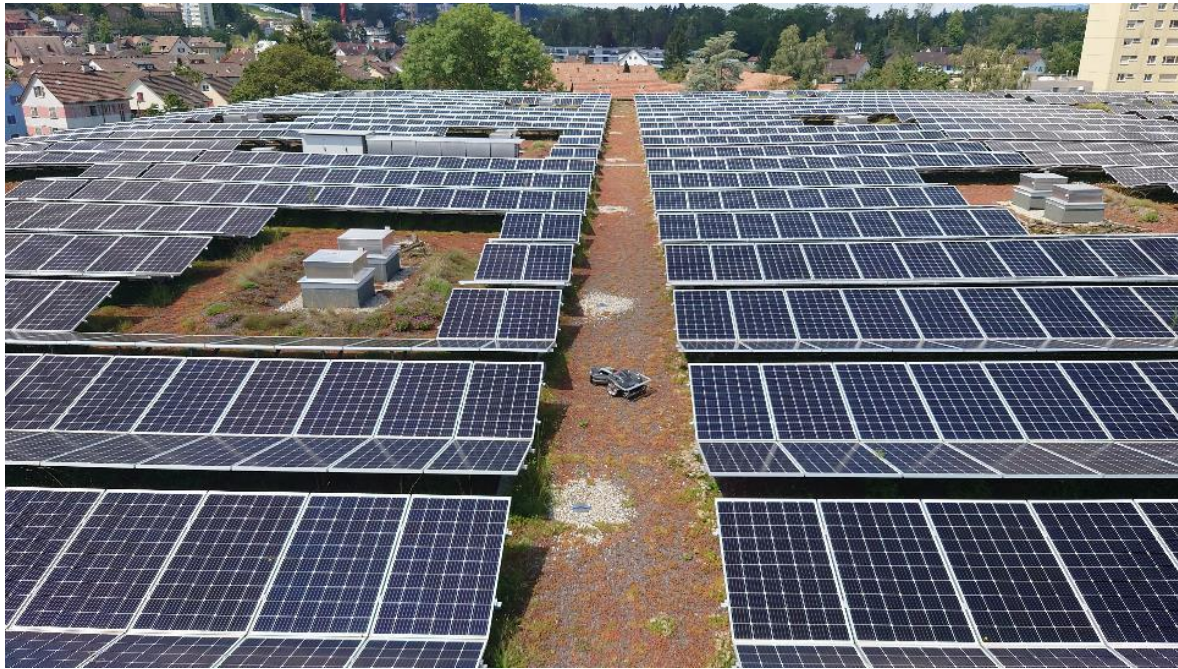
Energiegründach Lagerhaus des Opernhauses in Zürich in der Schweiz
