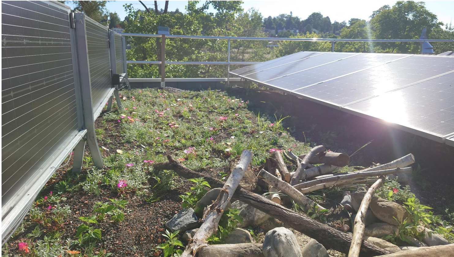
Das neuste Testdach Mattenbach in Winterthur in der Schweiz
